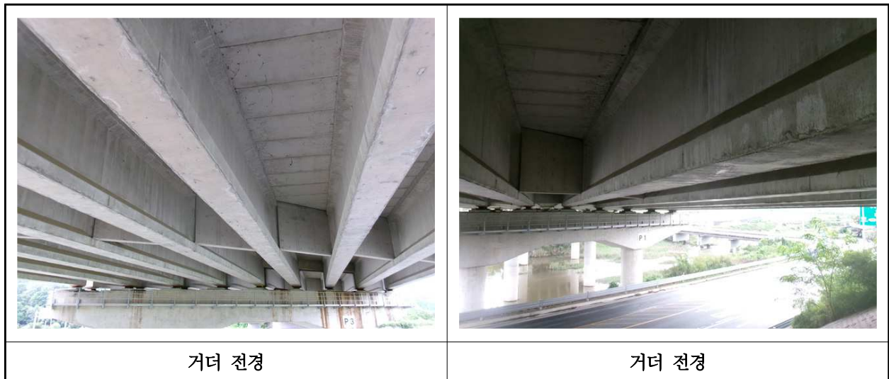
【사진 7.3.4】 거더 전경
