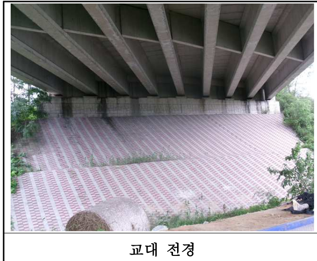
【사진 7.3.8】 교대 전경
