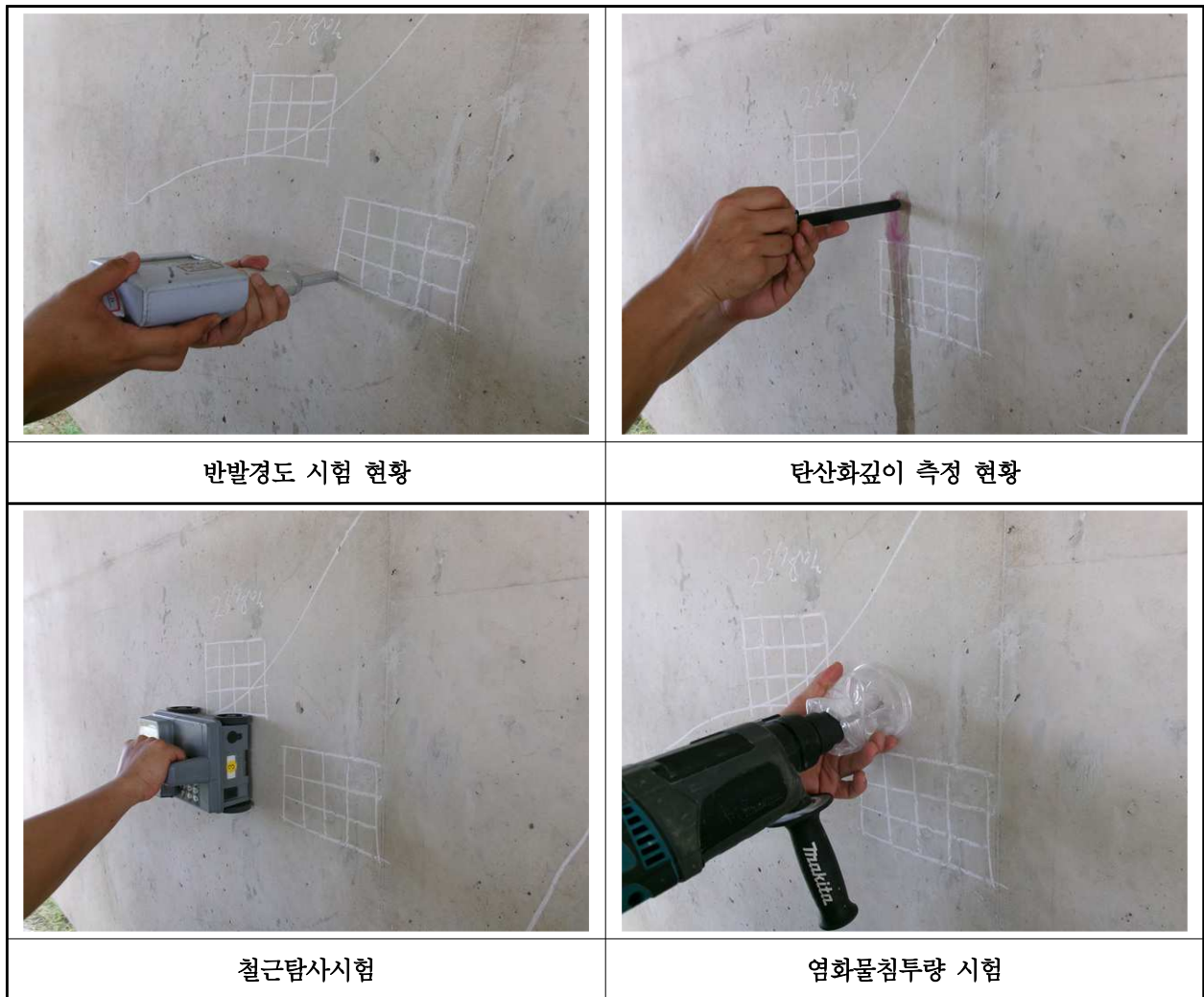
【사진 7.4.1】 콘크리트 내구성조사 현황
