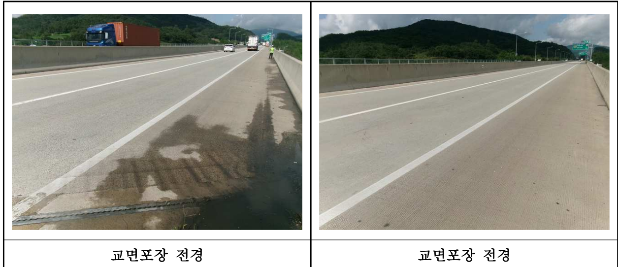
【사진 7.3.19】 교면포장 전경
