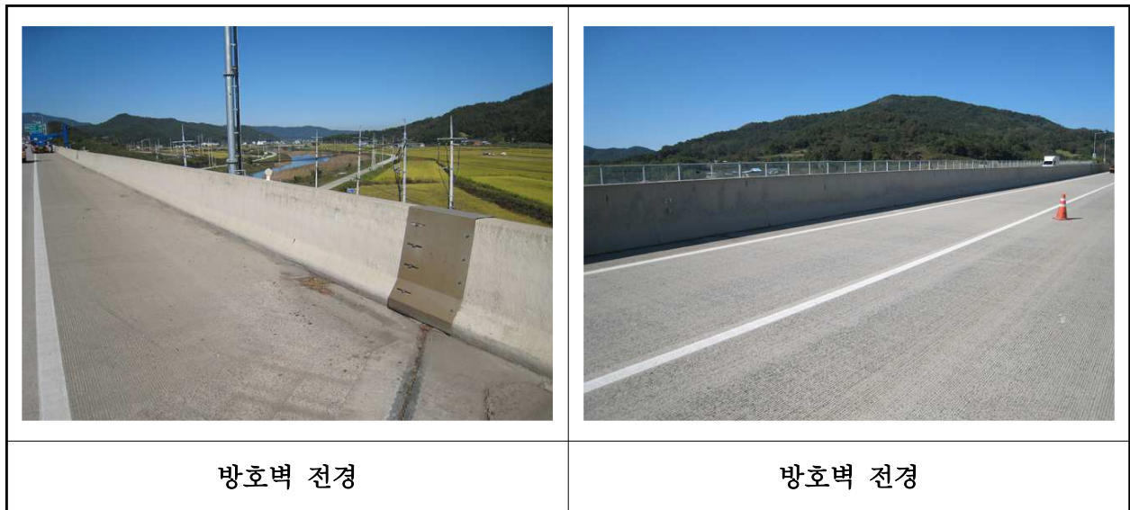
【사진 7.3.23】 방호벽 및 중앙분리대 전경
